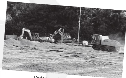
Verlegung Swisspor-Rasentrageschicht
